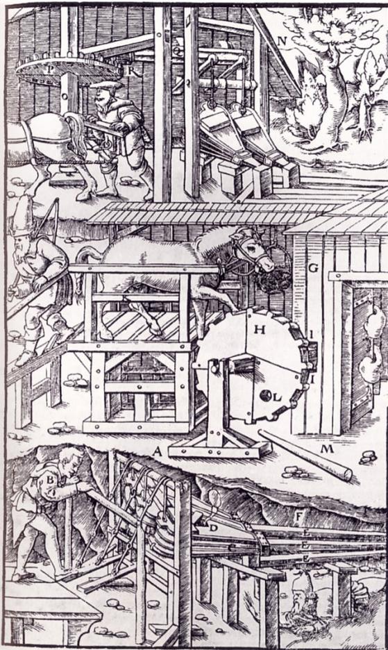
Abb. 36: Illustration zur Grubenbewetterung aus Georgius Agricolas „De re metallica“, Basel 1556, S. 176
